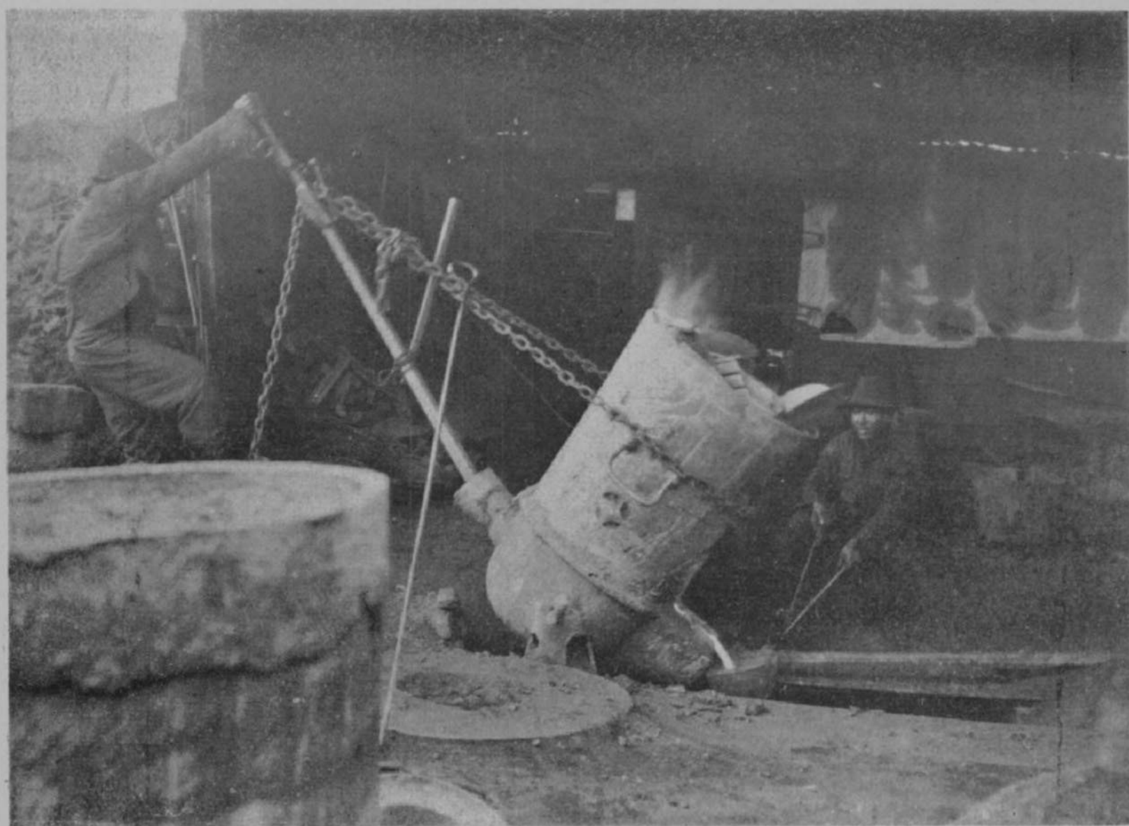
支那人の工業（その一）支那人鐵工所の朝鮮釜製造工場
