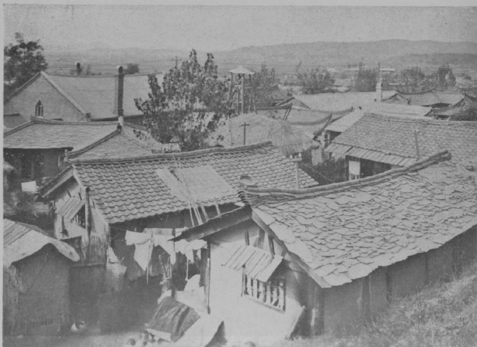
民家の屋根 根屋の家の民 (その二) 平壤外郊の家民葺瓦・葺タト・葺石・葺藁の根屋
