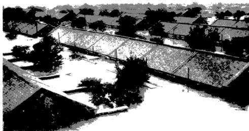
七月十八日 鐵道官舎ノ浸水狀況
