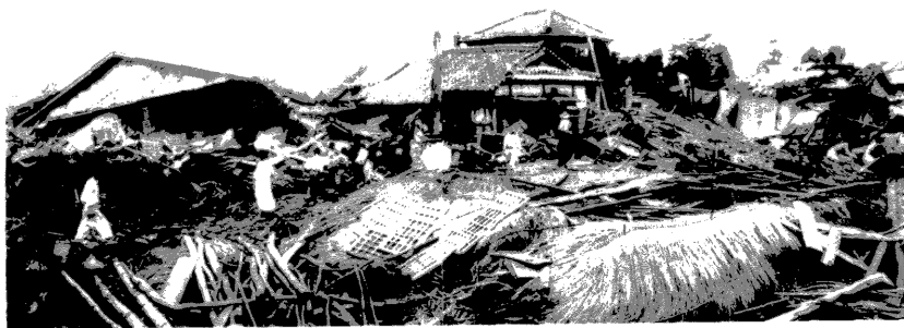
永 登 浦 驛 前 ノ 被 害 状 況
