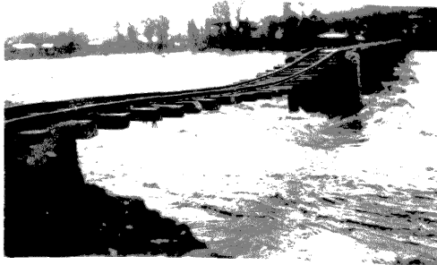
慶尙北道大邱東雲町 朝鮮鐵道大邱川鐵橋ノ破損 七月十二日正午
