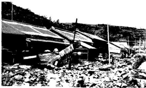
全羅南道麗水郡麗水埋立地ノ破損
