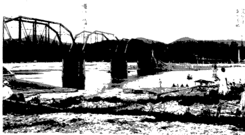
人 道 橋 中 央 築 堤 道 路 ノ 流 失 狀 況
