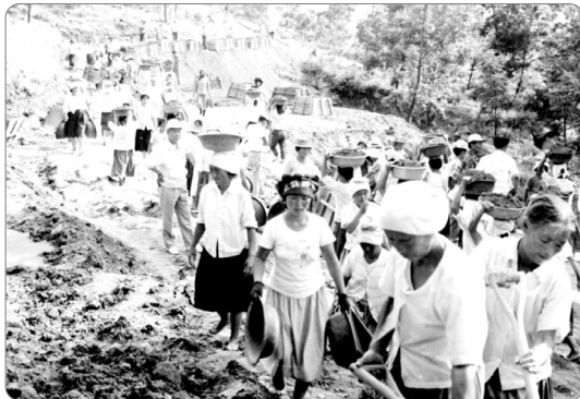
• 1974년 우암산 순환도로 공사
